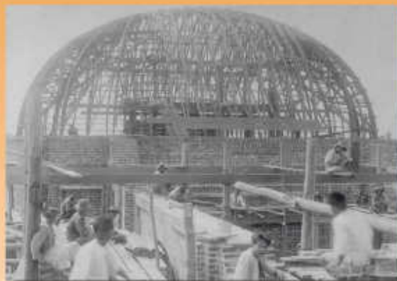
Manovali al lavoro nel cantiere del Palazzo del Trono.
