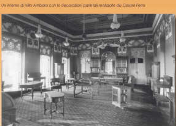
Un interno di Villa Ambara con le decorazioni parietali realizzate da Cesare Ferro
