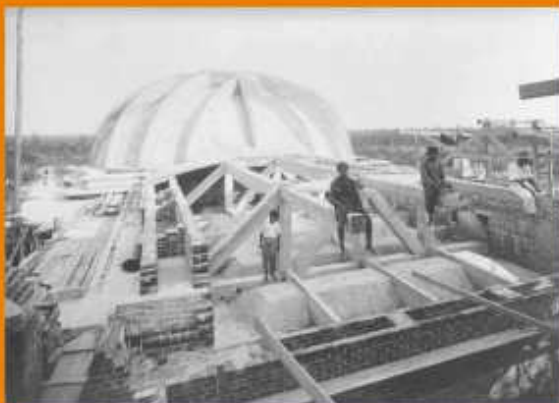
Manovali al lavoro sulle coperture in cemento armato del Palazzo del Trono.
